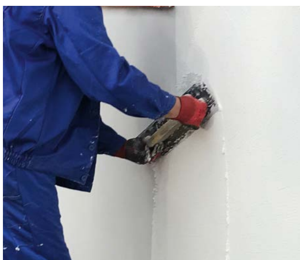
Fot. 11: Zaciągnięcie tynku SOLBET
