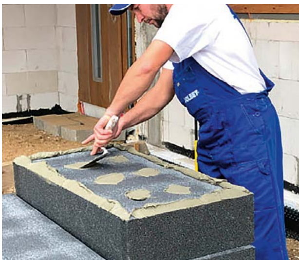
Fot. 3: Naniesienie zaprawy klejącej SOLBET Gabit Termo 1.6 do przyklejania styropianu
