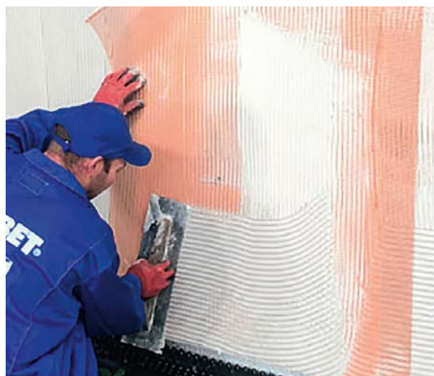
Fot. 8: Zaciągnięcie kleju Gabit Termo Plus 1.4 lub 1.5 na zatopioną siatkę tynkarską
