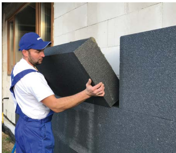
Fot. 4: Przyklejenie płyty styropianowej
