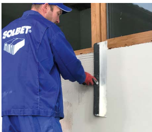
Fot. 9: Wygładzenie warstwy kleju Gabit Termo Plus 1.4 lub 1.5
