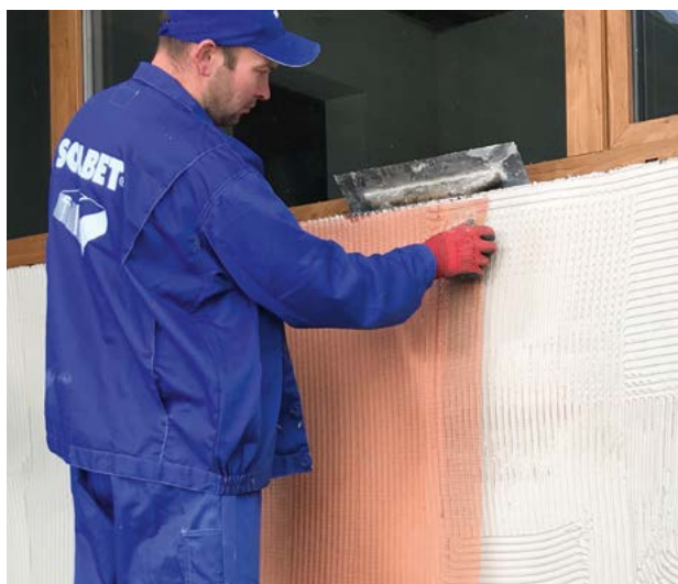
Fot. 7: Zatopienie siatki tynkarskiej w zaprawie klejącej Gabit Termo Plus 1.4 lub 1.5
