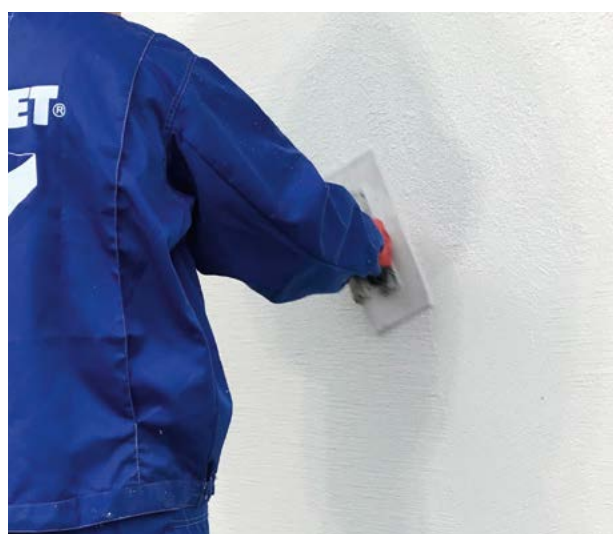
Fot. 12: Zatarcie tynku SOLBET
