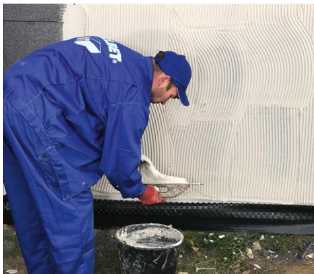
Fot. 6: Zaciągnięcie kleju do zatopienia siatki Gabit Termo Plus 1.4 lub 1.5
