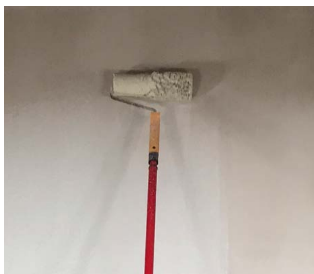
Fot. 10: Po wyschnięciu kleju zagruntowanie powierzchni za pomocą gruntu SOLPLAST PLUS 10.2
