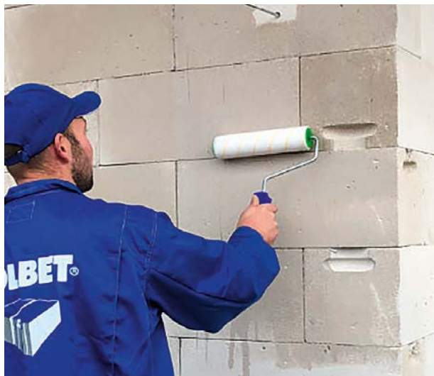
Fot. 2: Zagruntowanie powierzchni przeznaczonej do ocieplenia za pomocą gruntu Grunt Akryl Plus 12.2
