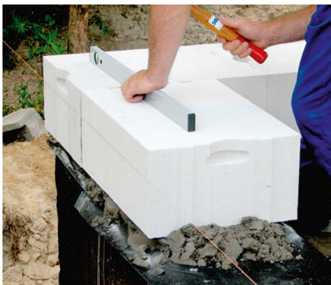
ZAPRAWA TRADYCYJNA ZASTOSOWANA DO MUROWANIA PIERWSZEJ WARSTWY BŁOCKÓW SŁUŻY RÓWNIEŻ DO NIWELOWANIA NIERÓWNOŚCI ŚCIANY FUNDAMENTOWEJ.
