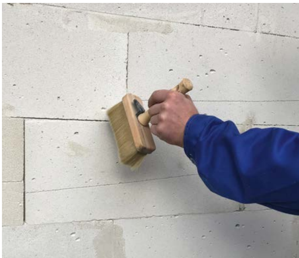
Fot. 1: Oczyszczenie ocieplanej ściany z kurzu i pyłu budowlanego
