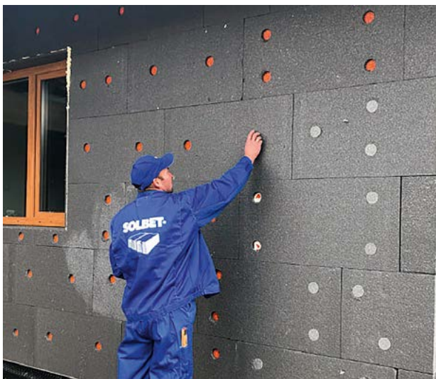
Fot. 5: Zamocowanie mechaniczne płyt styropianowych za pomocą kołków do systemu ociepleń
