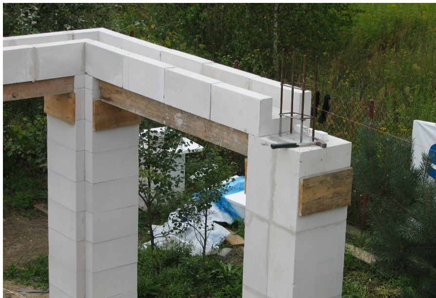
Do nadproży żelbetowych możemy wykorzystać szalunek tracony z kształtek U.
