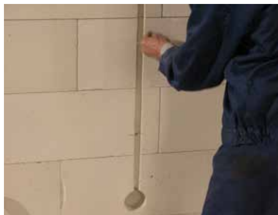
Rys. 6.17. Pionowa bruzda w murze z betonu komórkowego
