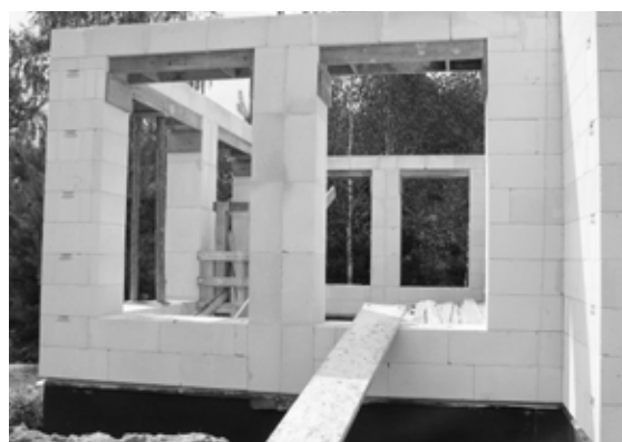
Ilustracja 9.71. Tak wygląda finalna konstrukcja filara wykonanego w kształtkach U. Jedno- lity materiał w konstrukcji murowej.
