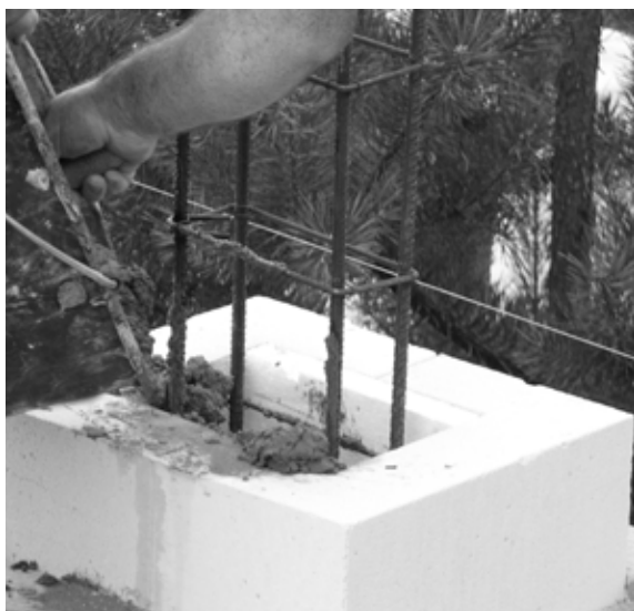
Ilustracja 9.68. Zalanie betonem szalunku i zbrojenia stupa
