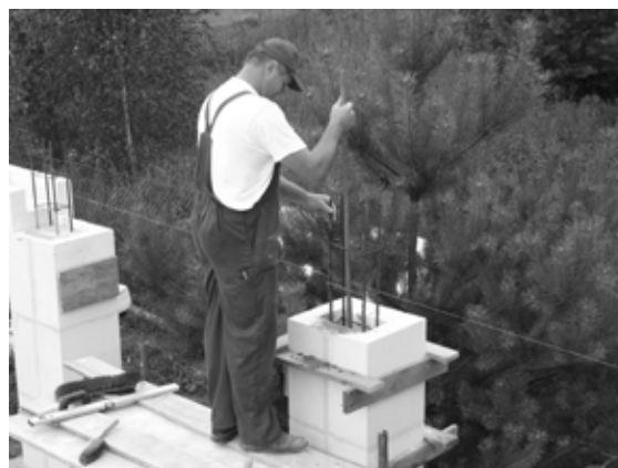
Ilustracja 9.70. Beton należy zagęścić
