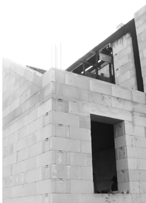
Ilustracja 1.2. Budowa z precyzyjnie wykonanymi murami z ABK
